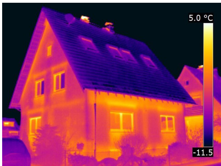
Geschossdecken und Rollladenkästen
