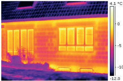
Thermografie einer monolithischen Außenwand
